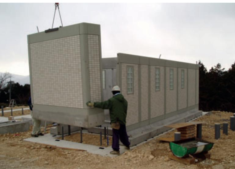
Fig. 2 y 3: Montaje de los elementos prefabricados en obra.
